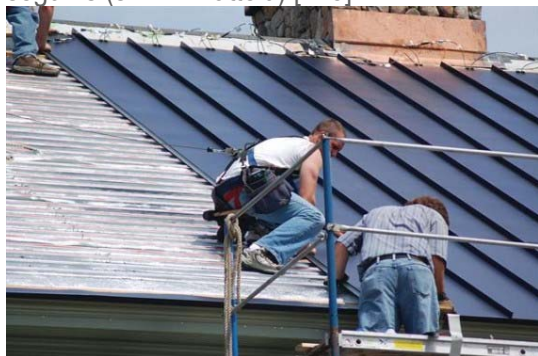
4.12. att. Saules divslāņu jumta sistēma apvieno plānu plēvi, metāla loksnes un saules enerģijas kolektoru. https://www.jetsongreen.com/2011/09/solar-sandwich-bipv-solar-thermal-englert.html
