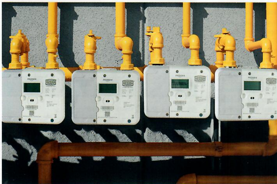
Pašlaik ES dabasgāzes sadales tīklos darbojas tikai daži VDS elementi – piemēram, dabasgāzes uzskaitē. Attēlā: viedie mājāsaimniecību dabasgāzes skaitītāji
